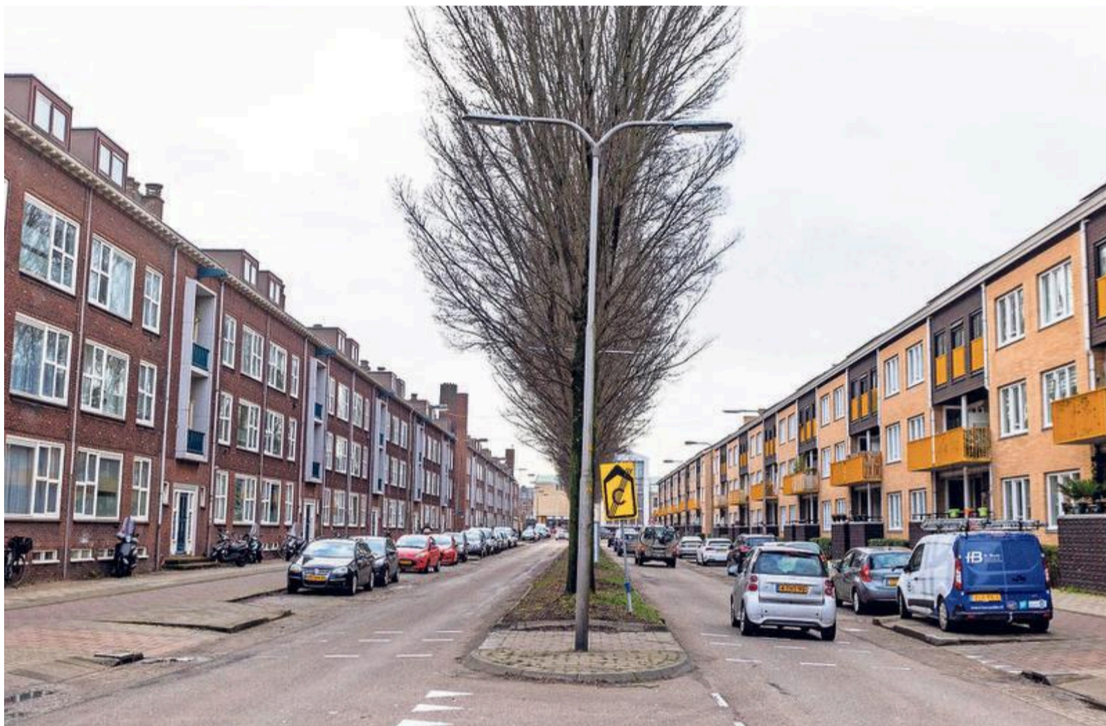
De Noostraat in IJmuiden: de flat rechts is gerenoveerd; in de flat links komt schimmel in de bergingen en in de woningen voor. FOTO UNITED PHOTOS/ROB VAN WIERINGEN
